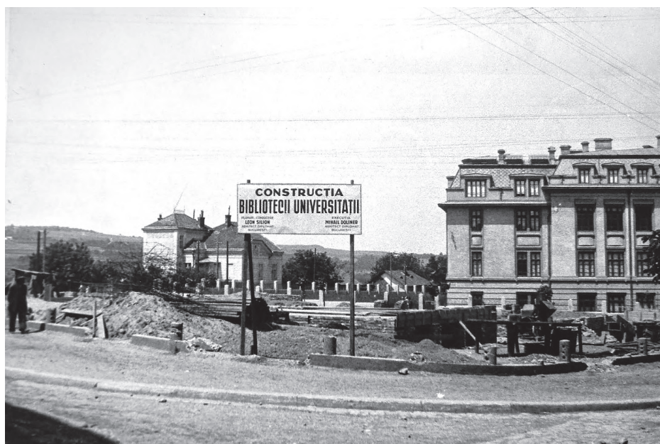
Clădirea bibliotecii Universității „Carol II” din Cernăuți, în șantier, 1938
