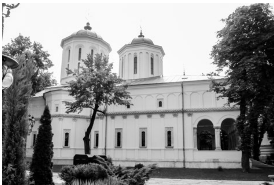
Fig. 30. Fațada de nord a bisericii reconstruite de la Cotroceni.
