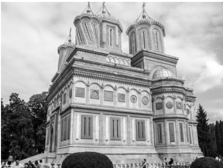
Fig. 4. Biserica Episcopală de la Curtea de Argeș la peste un secol de la restaurarea ei de arhitectul francez Andre Lecomte du Noüy.
