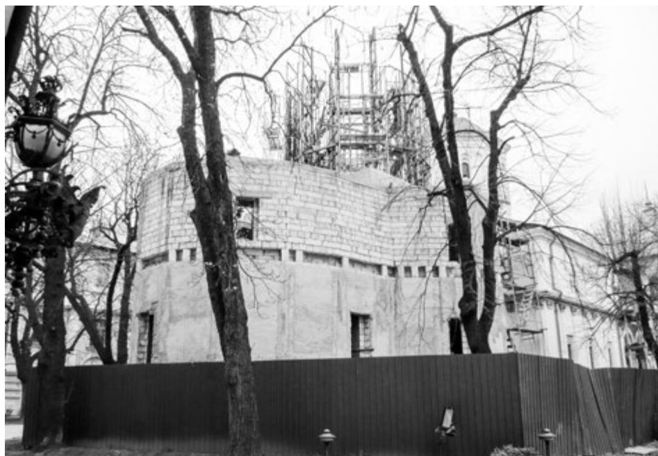
Fig. 29. Biserica de la Cotroceni în timpul reconstrucției din 2008. Se pot observa materialele utilizate pentru reconstituirea zidăriei: beton armat, BCA, tencuieli de ciment.
