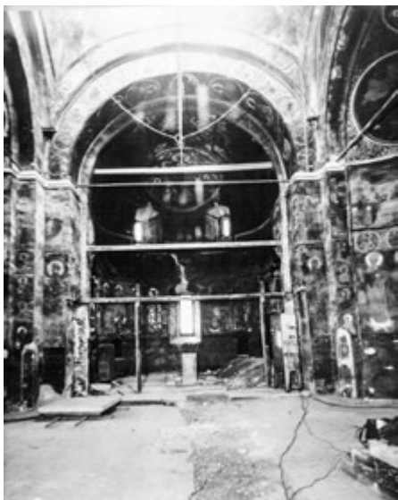
Fig. 31. Imagine de arhivă din interiorul Bisericii de la Cotroceni, spre absida altarului. Fotografia a fost realizată în timpul pregătirilor pentru demolarea bisericii.
