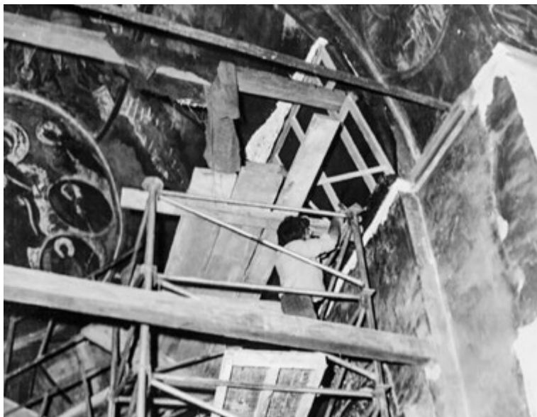
Fig. 15. Extragerea, în 1984, a unor fragmente de pictură murală din interiorul Bisericii de la Cotroceni. Pe schelă se afla pictorul restaurator Ion Neagoe.
