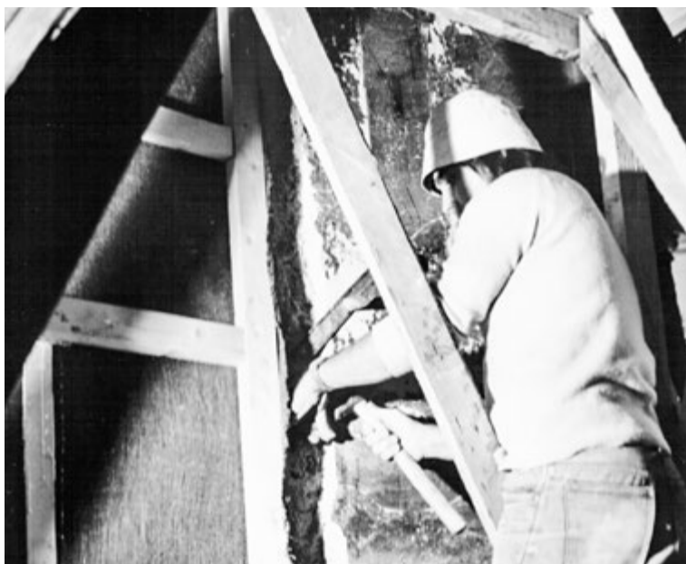
Fig. 16. Pictorul restaurator Viorel Grimalschi lucrează la extragerea prin metoda stacco a unui fragment de pictură murală din biserică de la Cotroceni. Operațiunile au precedat demolarea bisericii.
